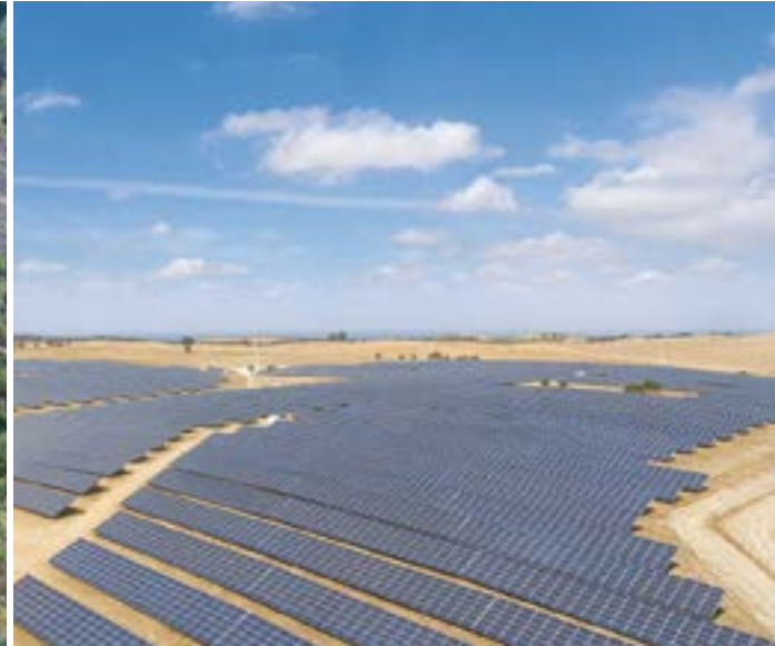
Solaranlage in Portugal
